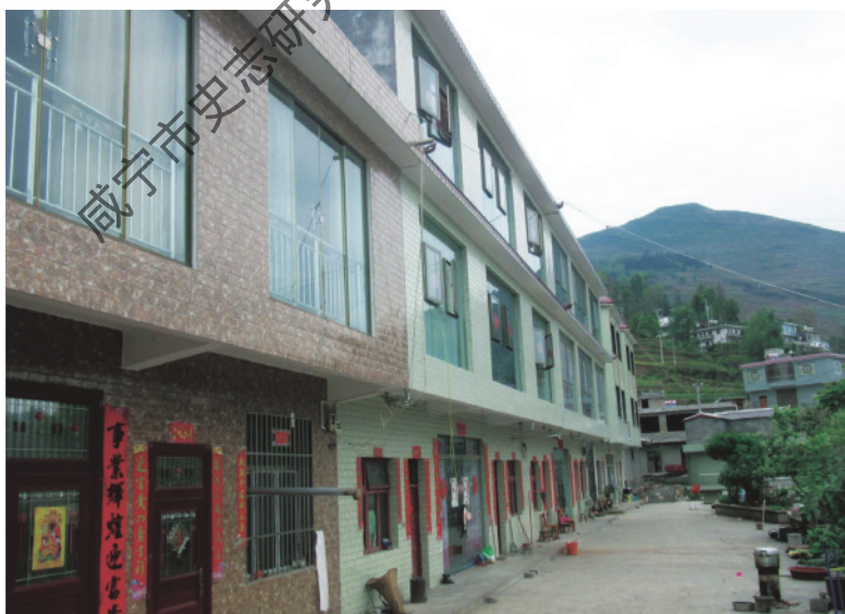
河坝煤矿为周边村民建的新农村
