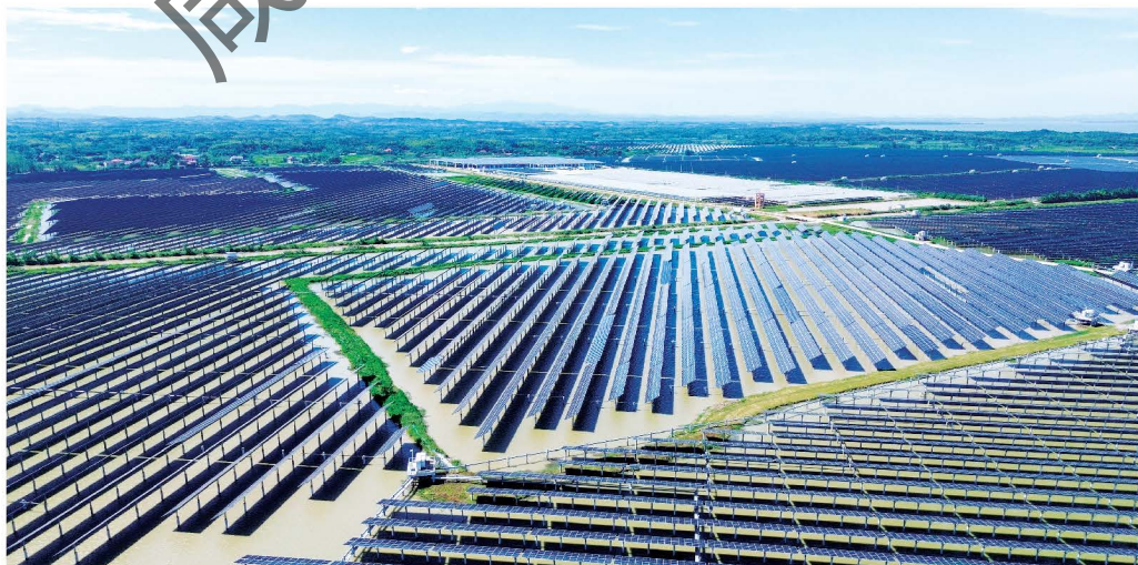
光伏发电华润赤壁日曜350兆瓦渔光互补光伏发电项目 (高璋琦 摄)
