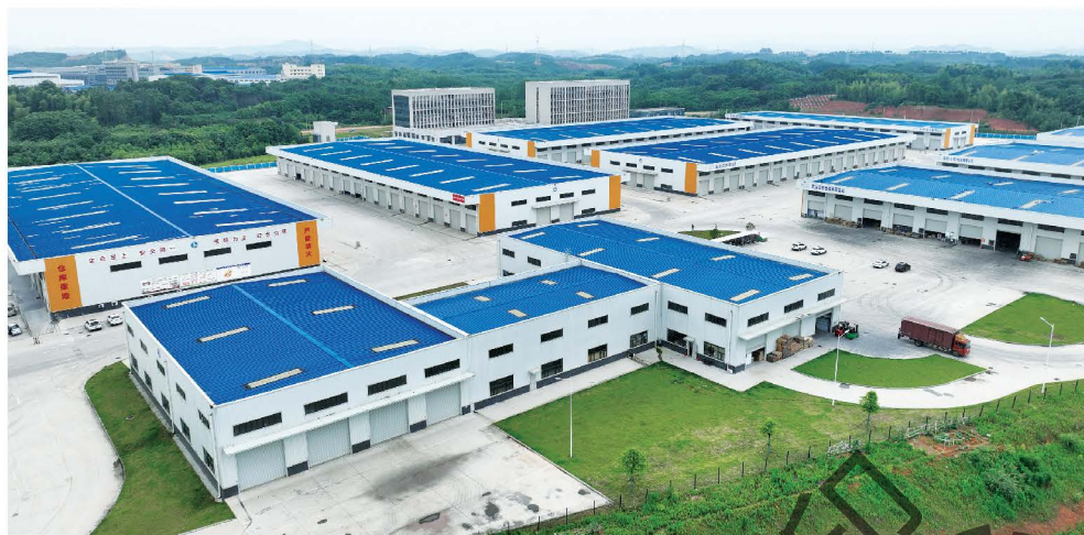
项目建设——咸宁公路港
