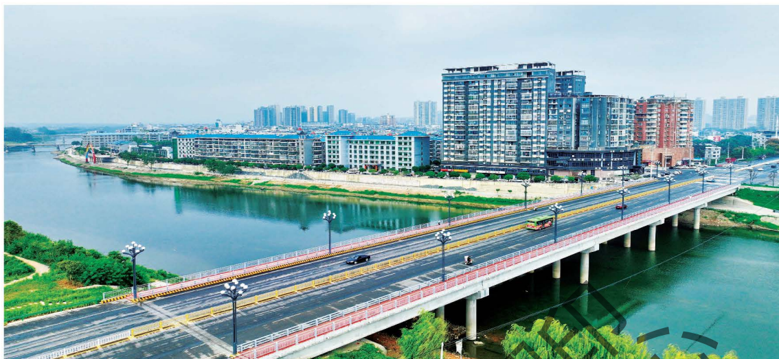
1月26日,拆除重建的崇阳四桥正式竣工通车
