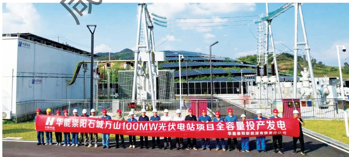
8月31日,石城镇方山村100MW光伏电站项目全容量投产发电
