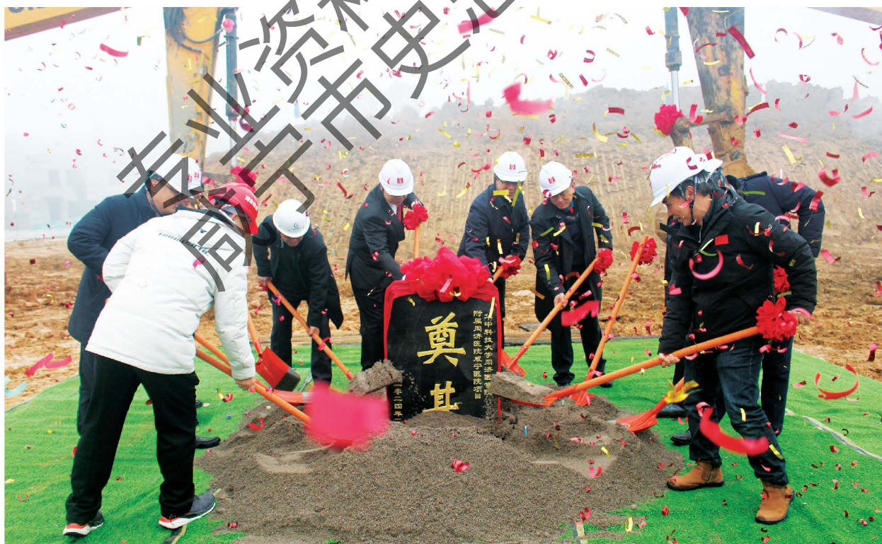
2月28日,同济咸宁医院项目(国家区域医疗中心)正式开工建设
